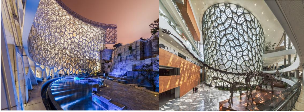
Görsel 13. Şanghay Doğa Tarihi Müzesi, cephe kurgusu, doğadaki nautilus kabuğu formunun dijital modelleme ile mimari şekle dönüştürülmüş bir örneğidir.
