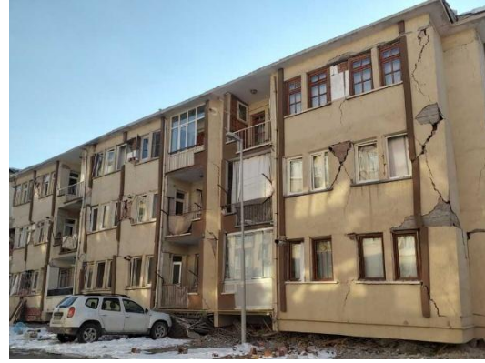
Görsel 3. İncelenen BA binaların deprem öncesi ve sonrası durumları
